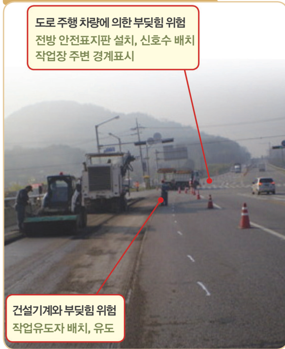
도로 유지, 보수 공사
